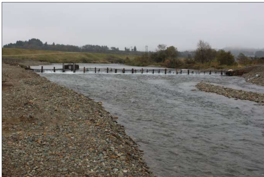
Рис. 9. Забойка на реке Сакэ Fig. 9. Hatchery's weir on the Sake River
