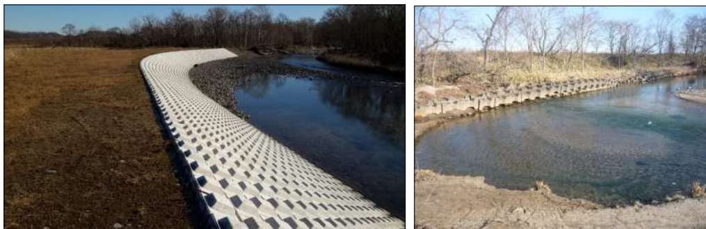
Рис. 15. Укрепленные берега реки Уэро в районе нерестилищ кеты (5,5 и 5,2 км от устья) Fig. 15. The sheltered banks of the Uyoro River in the area of chum salmon spawning grounds (5.5 and 5.2 km from the mouth)
