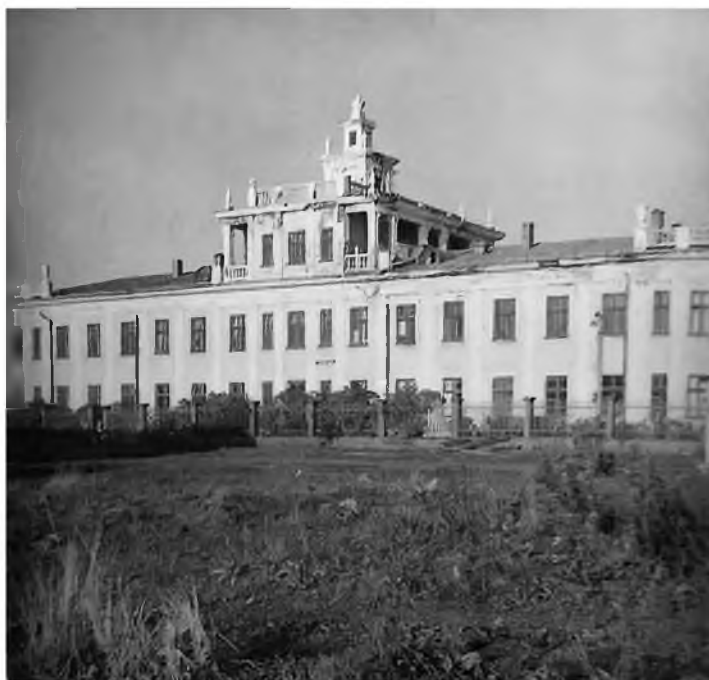
Здание СахТИНРО в п. Антоново
